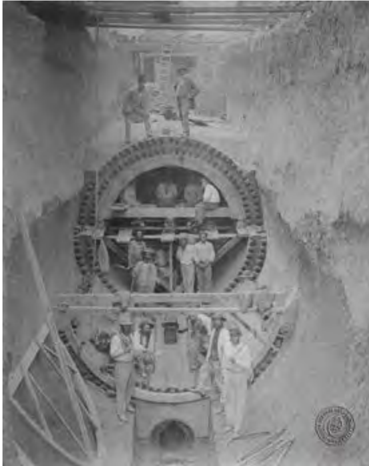
Construcción de la cloaca máxima de la ciudad de Buenos Aires, 1871.
